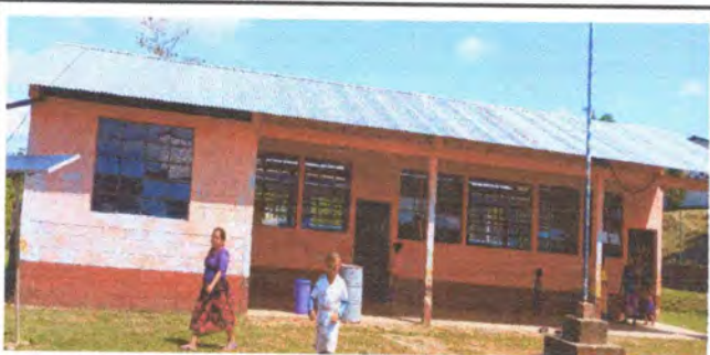
Foto 3: Aplicación a dos manos de pintura en exterior del establecimiento.
